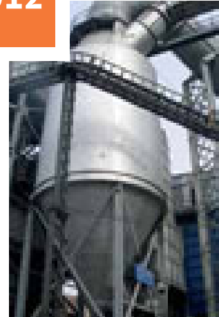
ТМК-RESITA Система газоочистки дуговой сталеплавильной печи и печи-ковша
