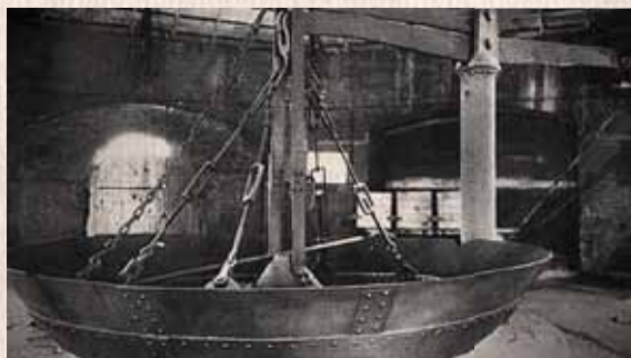
Конец XIX века. Агрегат для загрузки шихты и топлива в доменную печь
