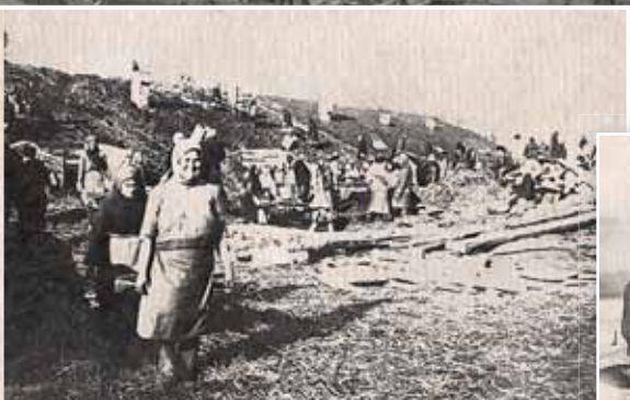
Строительство завода. 1931 год
