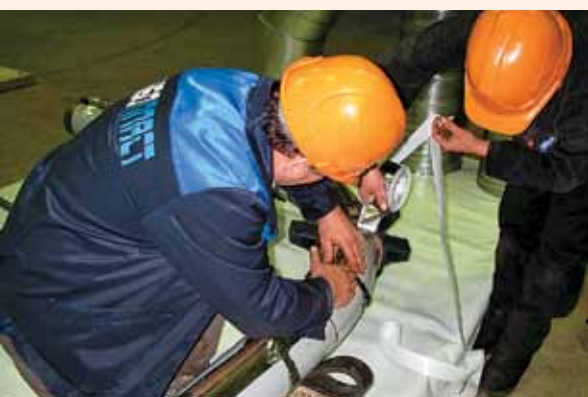
Монтаж системы подогрева трубопровода на соединительной детали
