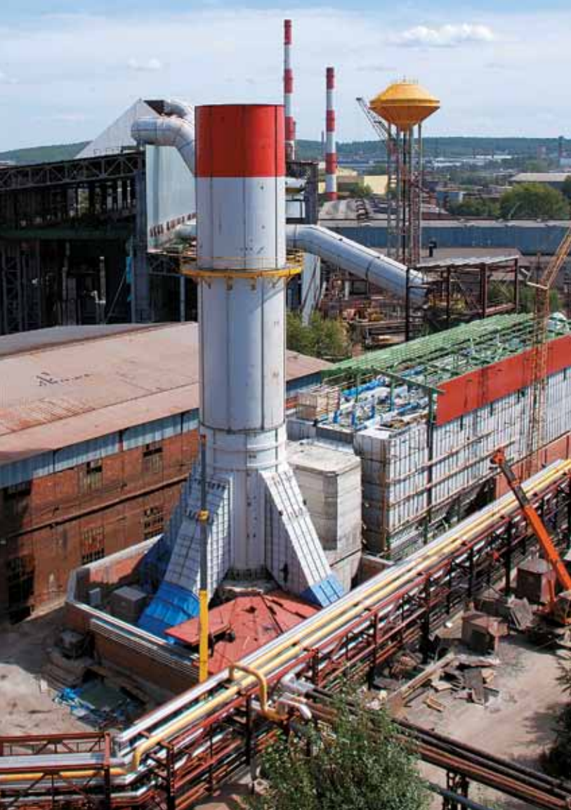
Газоочистка электросталеплавильного цеха СТЗ
