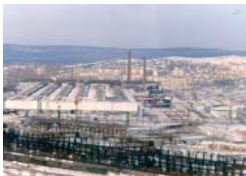
Панорама Северского трубного завода
