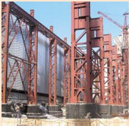
Так выглядит строящаяся МНЛЗ
