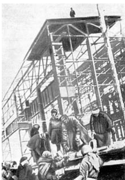
Строительство трубопрокатного цеха в конце 20-х годов
