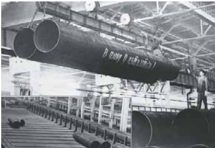
1971-й. Последний год 9-й пятилетки. Первая продукция трубоэлектросварочного цеха
