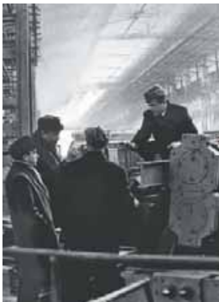
1970-й. Николай Александрович Богатов (справа), с 1969 по 1973 гг. — главный инженер, с 1973 по 1976 гг. — директор ВТЗ, на монтаже и наладке оборудования
