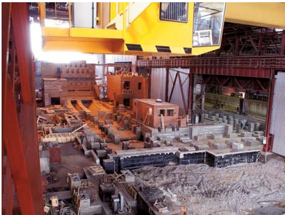
Строительство МНЛЗ на Северском трубном заводе идет полным ходом
