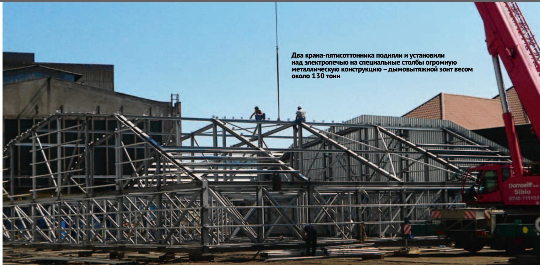
**Два крана-пятисоттонника подняли и установили над электропечью на специальные столбы огромную металлическую конструкцию – дымовытяжной зонт весом около 130 тонн**
