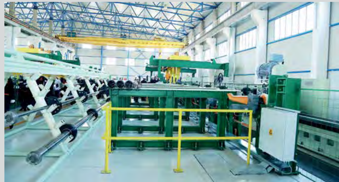
Оборудование финишной отделки продукции, TMK-ARTROM
