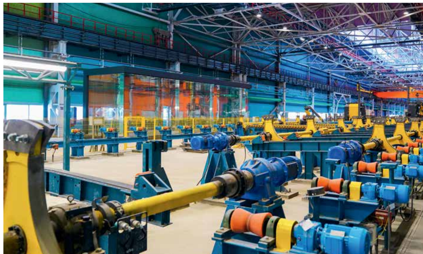
Участок отделки труб из нержавеющей марок стали
